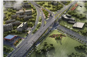
90年代杨高中路改建工程公路
